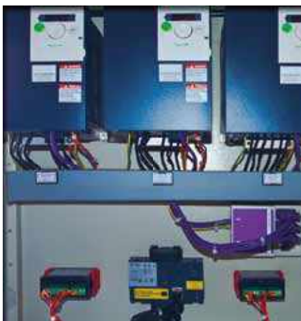
Sensori temperatura e gruppo inverter Temperature sensor and inverter
