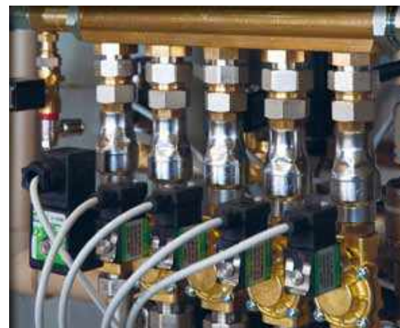
Gruppo elettrovalvole Inside of the electrical pump
