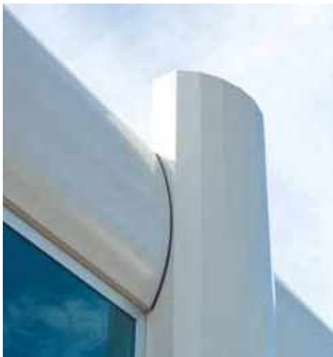
Particolare copertura View of the cover
