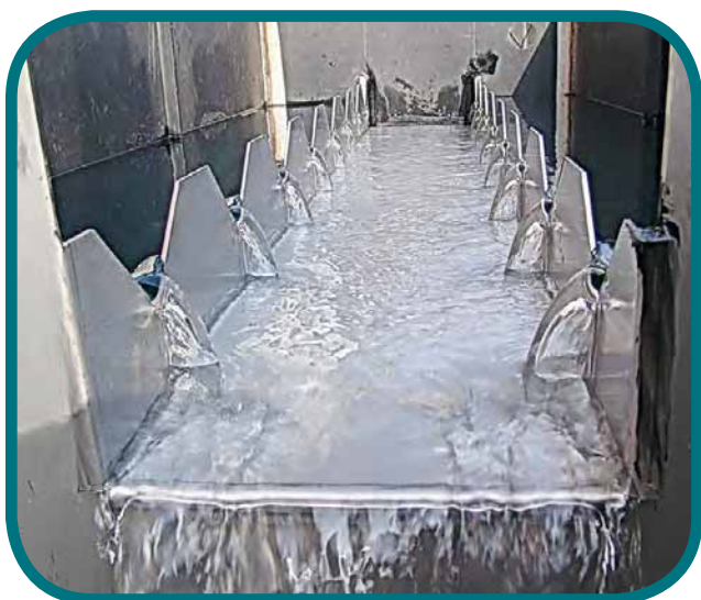
Uscita acqua chiarificata, con canalina Thompson Clarified water outlet, with Thompson channel
