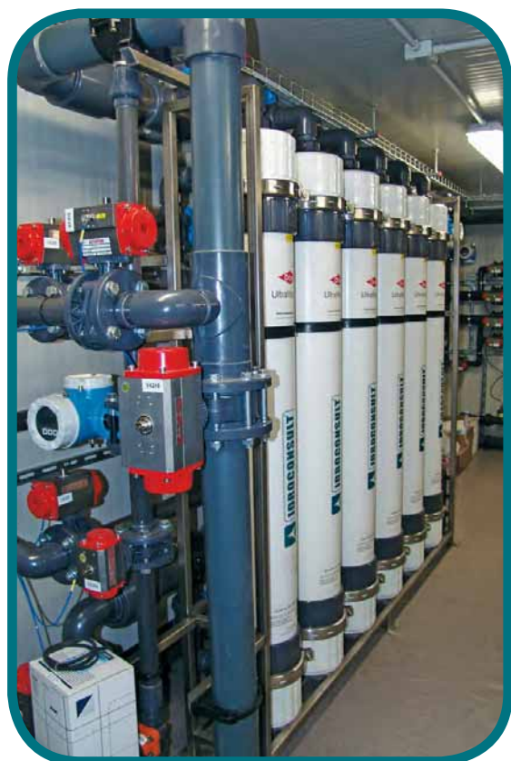
Ultrafiltrazione per acque di scarico Portata 15 m 3 /ora Ultrafiltration system for wastewater Flow rate 15 m 3 /h
