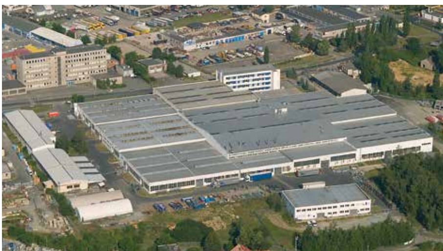
Stabilimento di produzione a Plzen con una zona di produzione coperta di 29.082m 2
