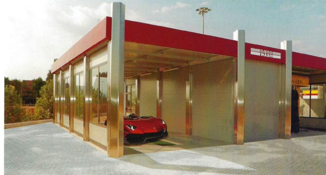
Posteriore locale tecnico con copertura portale Back side of the control room with rollover cover
