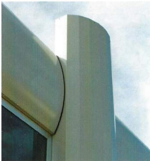
Particolare copertura View of the cover
